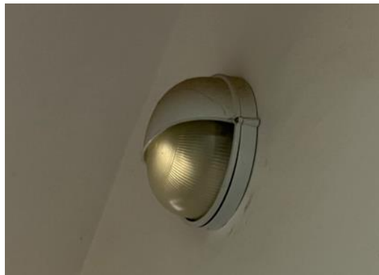
Slika 3. Prikaz postojeće rasvjete na stubištu.
