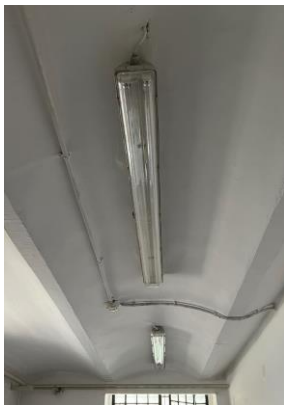
Slika 2. Prikaz postojeće rasvjete u podrumu.
